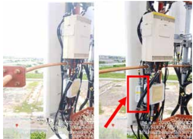
ก่อนการติดตั้ง
